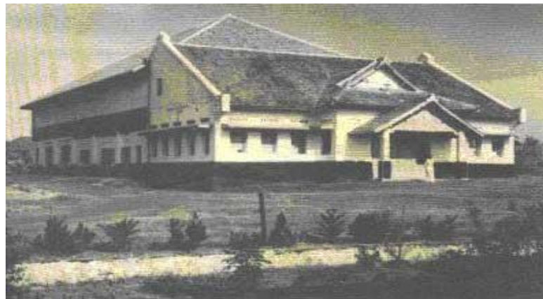
Gambar II.3 Gedung Bagian Pensiun dan Tunjangan yang berada di Jl Suropati 50 Bandung
