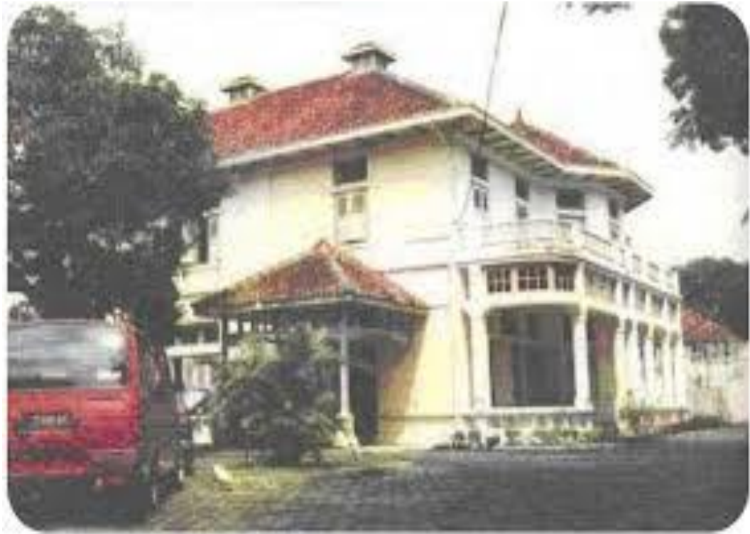
Gambar 2.2 Gedung kantor KUP bagian TU Kepegawaian Yogyakarta
