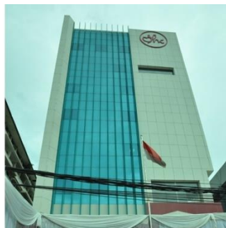
Gambar II.1 Gedung RS Jantung Jakarta
