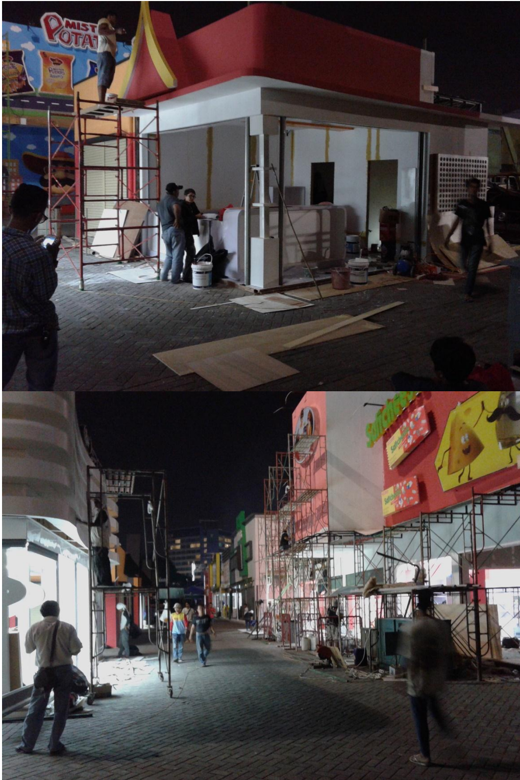
Gambar 1 : Pembangunan dan Persiapan Stand
