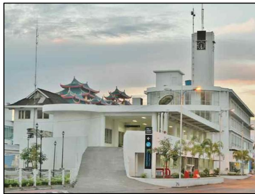
Tampak Depan Area Masuk Railink Stasiun
