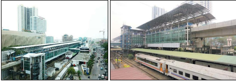
Proyek Jalan Layang Kereta Api Bandara dari Bandara Kuala Namu, Medan
