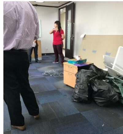
Situasi pada saat mengecek ruangan
