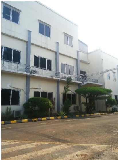
Gambar II.9 Gedung PLN Pondok kopi
