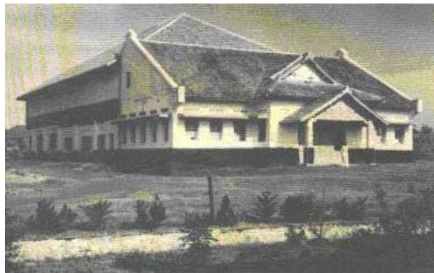
Gambar II.4 Gedung Bagian Pensiun dan Tunjangan di Bandung
