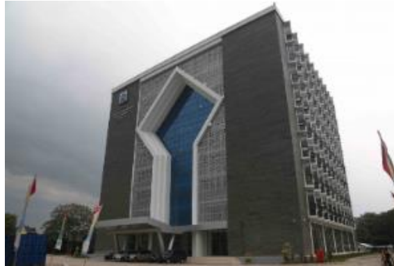
Gambar II.12 Pembangunan Gedung UIN Syarif Hidayatullah
