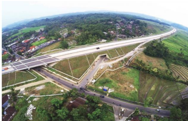
Gambar II.11 Pembangunan Jalan Tol Solo, Kertosono
