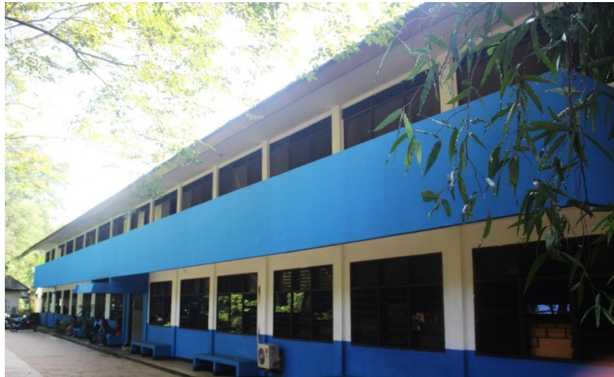
Gambar 1 Gedung Yayasan Pa van der Steur
