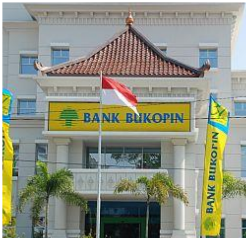
Gambar II. 6 - Bangunan Bank Bukopin
